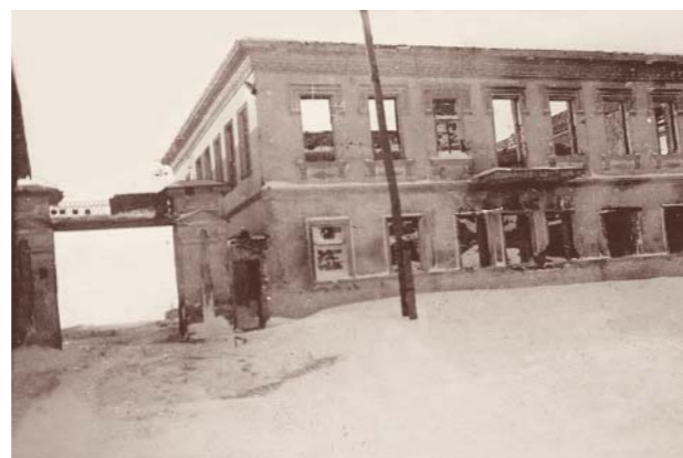
Разрушенное здание общежития учительского института на улице Ленина. Старый Оскол.
