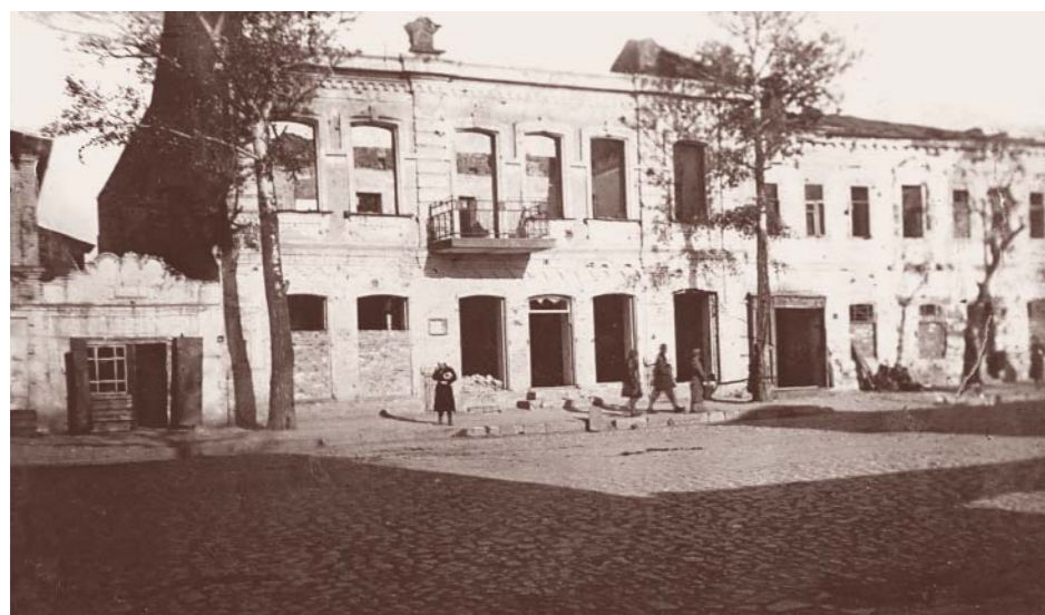
Разрушенное здание исполкома райсовета депутатов трудящихся. Старый Оскол. Из архива Старооскольского краеведческого музея
