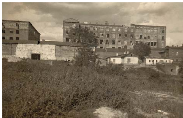
Разрушенное здание геологоразведочного техникума. Старый Оскол.
