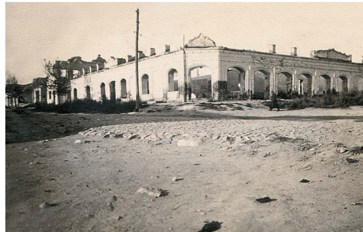
Разрушенное здание торговых рядов. Старый Оскол. Из архива Старооскольского краеведческого музея
